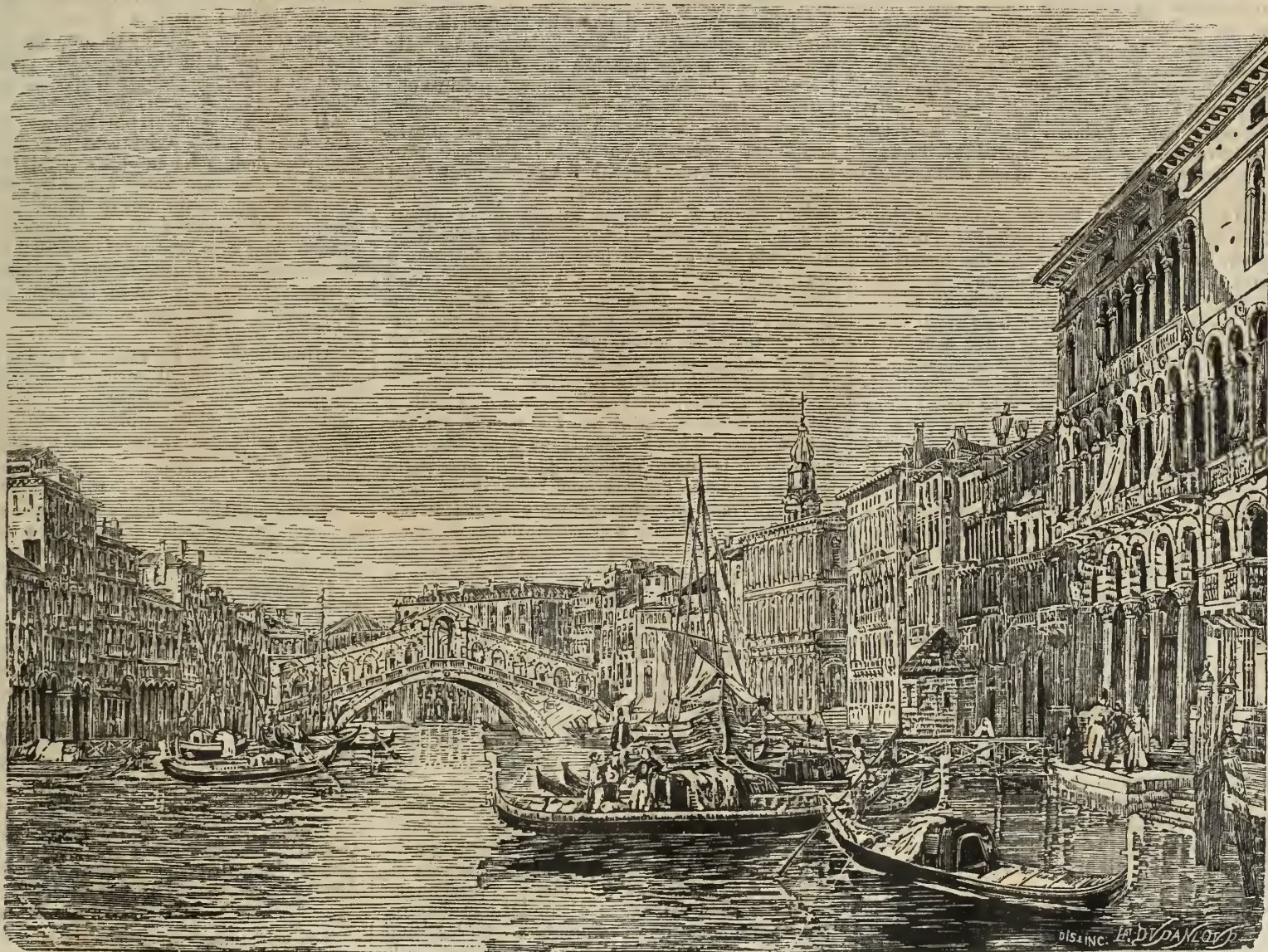
PONTE DI RIALTO IN VENEZIA.
